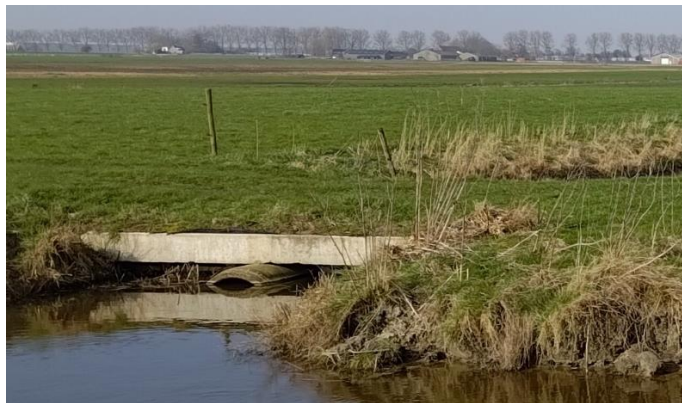
Figuur 10: Zijkant van een brug. Type vergelijkbaar met vindplaats 5.
