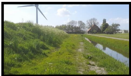
Figuur 7 Slib-depot Dronrijp
